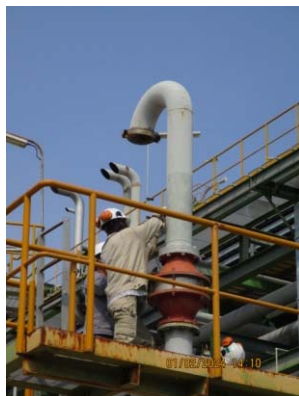
ปล่อง Charcoal Adsorber 3 (D-1510A)
