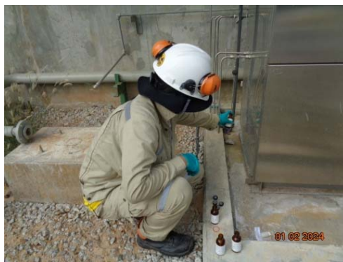
น้ำทิ้งหลังผ่านการบำบัดใน Final Polishing Buffer Tank (W3)
